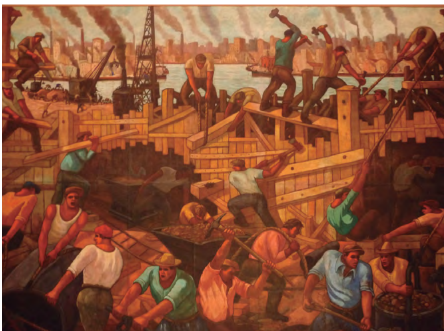
Figura N° 5. Foto de la obra restaurada.
