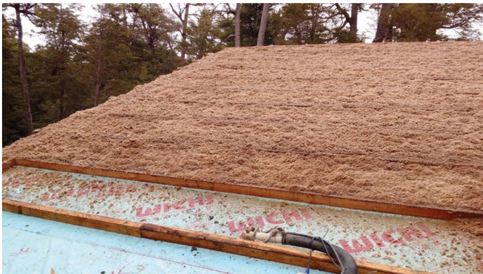
Figura N° 1. Aislamiento de Celulosa instalado en techo. Fuente: Publicación empresa local (Prohouse - Aislación Ecológica).
