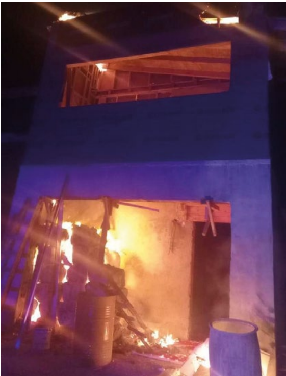
Figura N° 4. 3:34 h - Incendio en vivienda en obra, entre techo aislado con celulosa. Las unidades se retiran a las 7:45 h. Luego, en horas de la tarde, intervienen nuevamente por un llamado de emergencia por reinicio. Aproximadamente, se aplicaron 70.000 litros de agua. Fuente: Gentileza Bomberos Voluntarios de Villa La Angostura.
