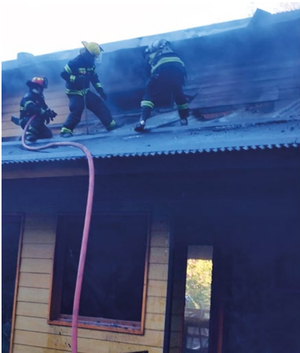
Figura N° 6. Incendio declarado de vivienda de dos plantas. Aislamiento de paredes y techos con celulosa. Bomberos realizan la apertura de techo de ambas pendientes de techo para remoción y ataque directo con línea de alto caudal, con chorro pleno para romper la estructura pirolizada. Fuente: Gentileza Bomberos Voluntarios Villa La Angostura.
