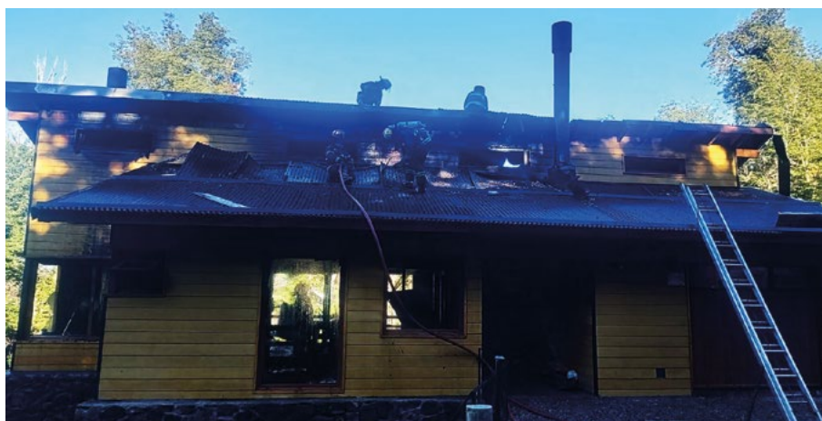
Figura N° 7. Tareas de remoción de chapas. Puede observarse que la celulosa se mantenía combustionando debajo de las chapas, en las zonas donde se presumía habría comenzado el incendio.
